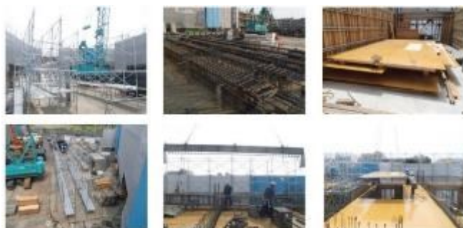
地組(足場・型枠・鉄筋)のイメージ
