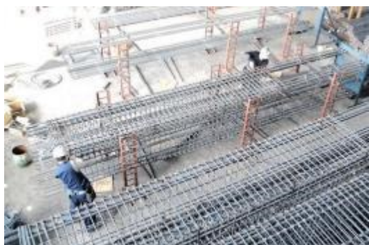
梁鉄筋工場地組
